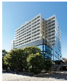
B-12 Primegate 飯田橋
