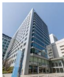
A-52 大宮センタービル
