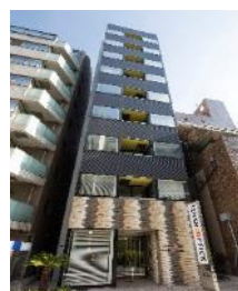
A-73 天翔新橋5丁目ビル
