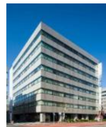
A-39 イトーピア清洲橋通ビル
