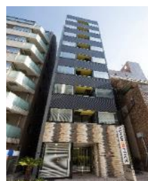
A-73 天翔新橋5丁目ビル
