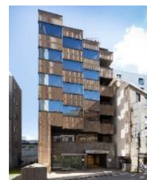
A-68 NRT神田須田町ビル
