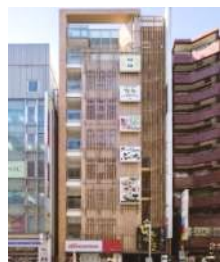
C-1 小滝橋パシフィカビル
