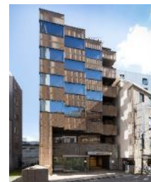
A-68 NRT神田須田町ビル
