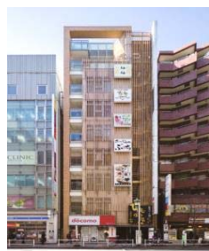
C-1 小滝橋パシフィカビル
