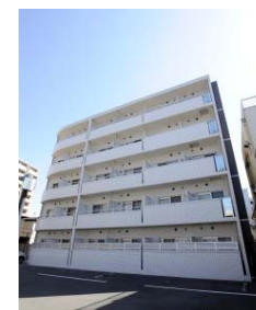
B-6 シーム・ドール筒井
