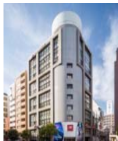
A-42 サンワールドビル
