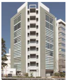
A-59 友泉東日本橋駅前ビル
