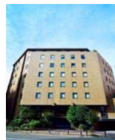
A-56 ホームットホライゾンビル
