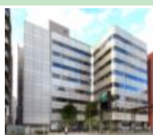
A-13 東池袋センタービル
