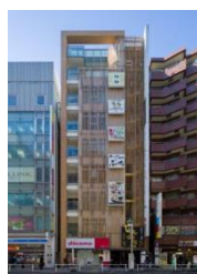
C-1 小滝橋パシフィカビル
