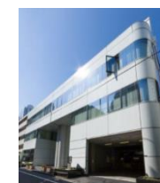
A-28 西新橋三晃ビル
