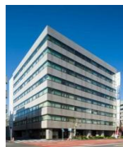
A-39 イトーピア 清洲橋通ビル
