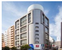
A-42 サンワールドビル
