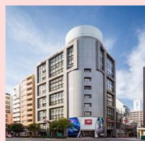
A-42 サンワールド ビル
