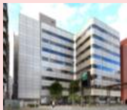
A-13 東池袋 センタービル
