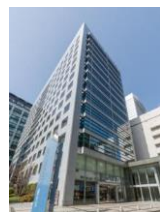
A-52 大宮センタービル
