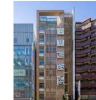
C-1 小滝橋パシフィカビル
