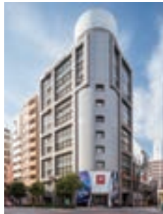
A-42 サンワールドビル
