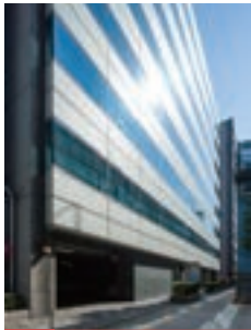
A-37 板橋本町ビル
