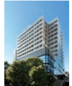
B-12 Primegate 飯田橋
