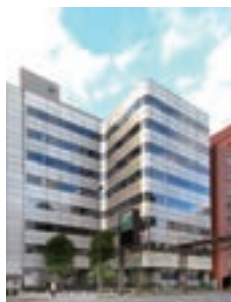
A-13 東池袋センタービル
