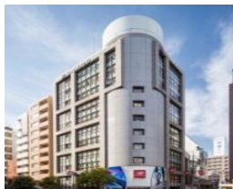
A-42 サンワールドビル
