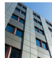
A-23 イトーピア 岩本町ANNEXビル
