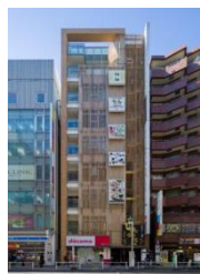
C-1 小滝橋パシフィカビル
