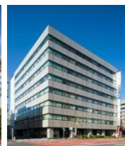
A-39 イトーピア 清洲橋通ビル
