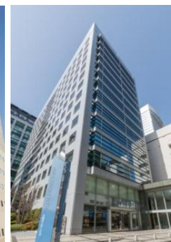
A-52 大宮センタービル
