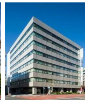
A-39 イトーピア 清洲橋通ビル
