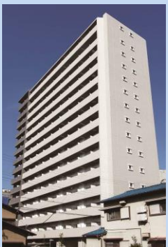
B-18 スプラッディッド新大阪Ⅲ (大阪府大阪市)
