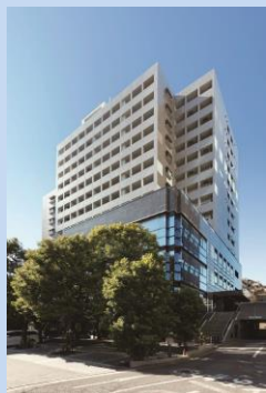
B-12 Primegate 飯田橋 (東京都新宿区)
