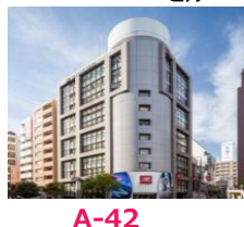
A-42 サンワールドビル
