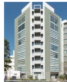
A-59 友泉東日本橋駅前ビル
