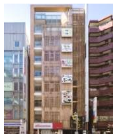
C-1 小滝橋パシフィカビル
