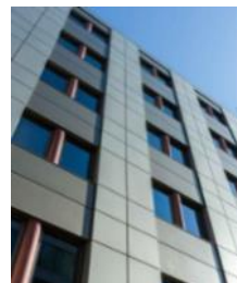
A-23 イトーピア岩本町ANNEXビル
