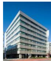
A-39 イトーピア清洲橋通ビル
