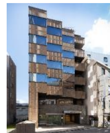
A-68 NRT神田須田町ビル
