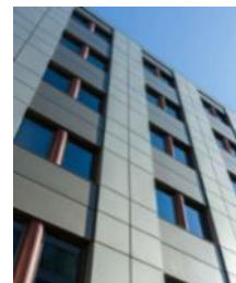
A-23 イトーピア岩本町ANNEXビル
