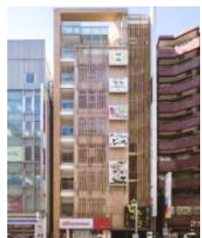
C-1 小滝橋パシフィカビル
