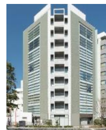
A-59 友泉東日本橋駅前ビル
