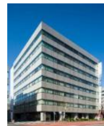
A-39 イトーピア清洲橋通ビル
