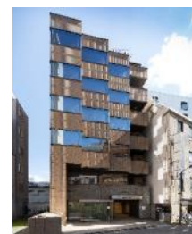
A-68 NRT神田須田町ビル
