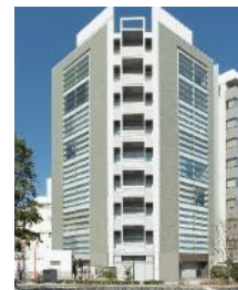
A-59 友泉東日本橋駅前ビル
