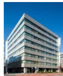
A-39 イトーピア清洲橋通ビル
