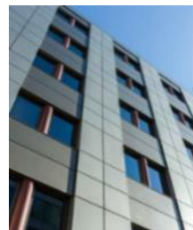
A-23 イトーピア岩本町ANNEXビル
