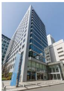
大宮センタービル
