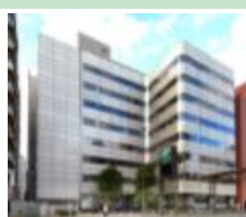
A-13 東池袋センタービル
