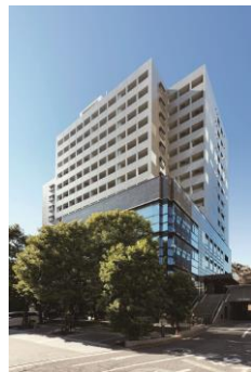
B-12 Primegate 飯田橋
